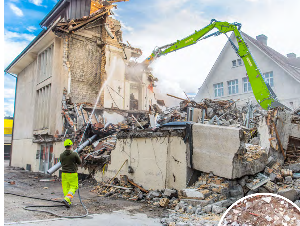
Aus dem Abbruch können viele Materialien wiederverwertet werden
